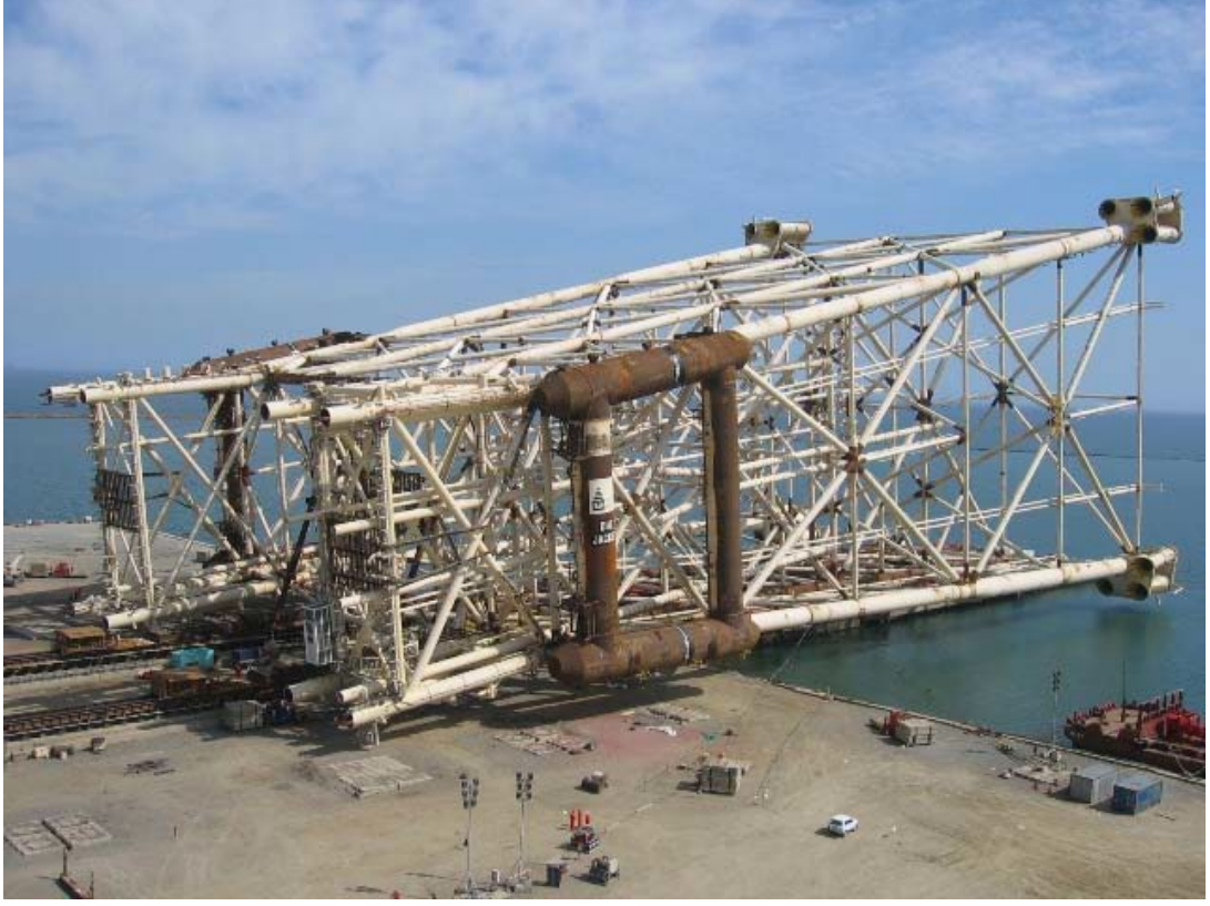
Şekil 5.7: DərSG-YBQTT platformasının dayaq bloku yükləmə zamanı
