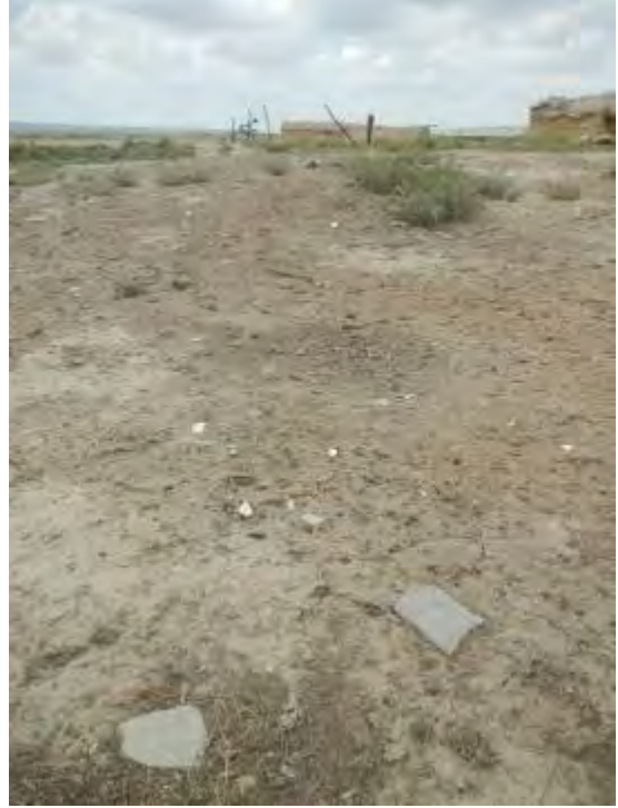
CQBKG KG20-də sementli asbest təbəqəsinin qırıntıları
