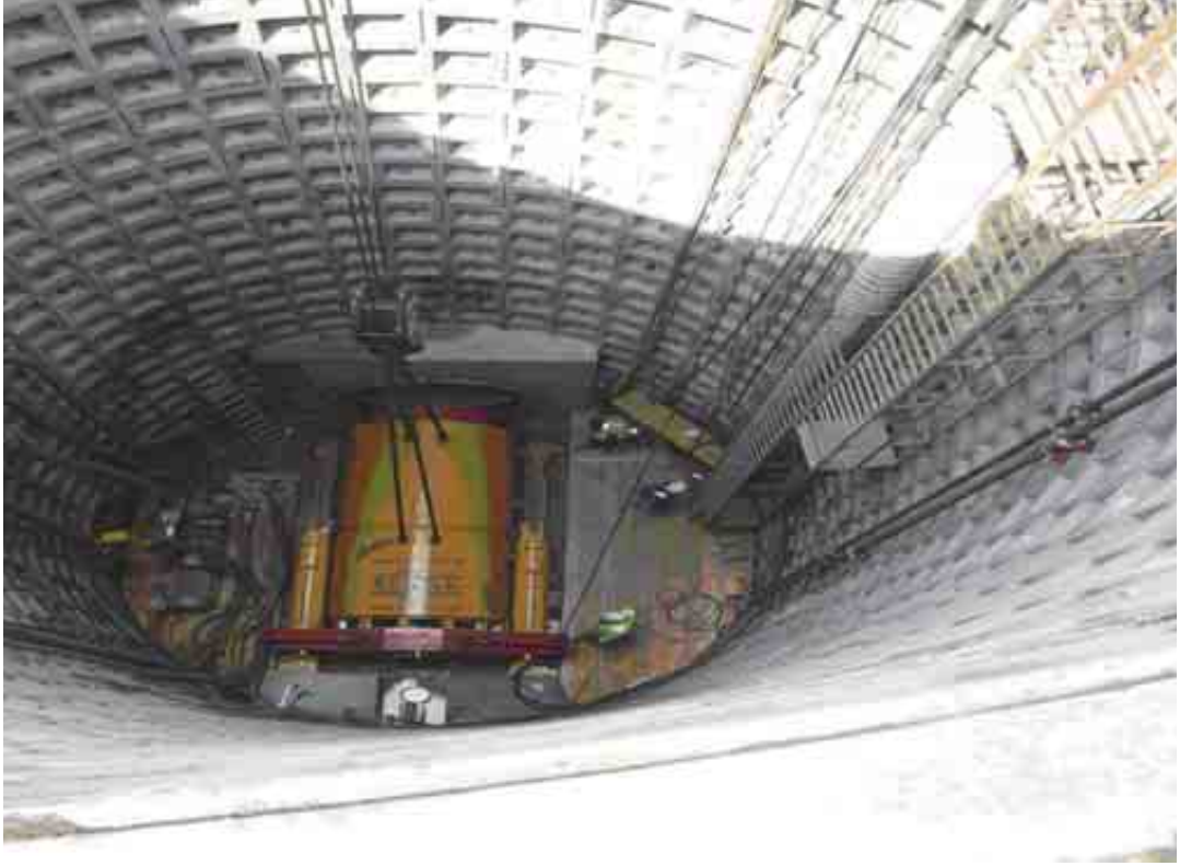
Fotoşəkil 5-6: Mikrotunelin Giriş Gövdəsi – Yuxarıdan Görünüş
