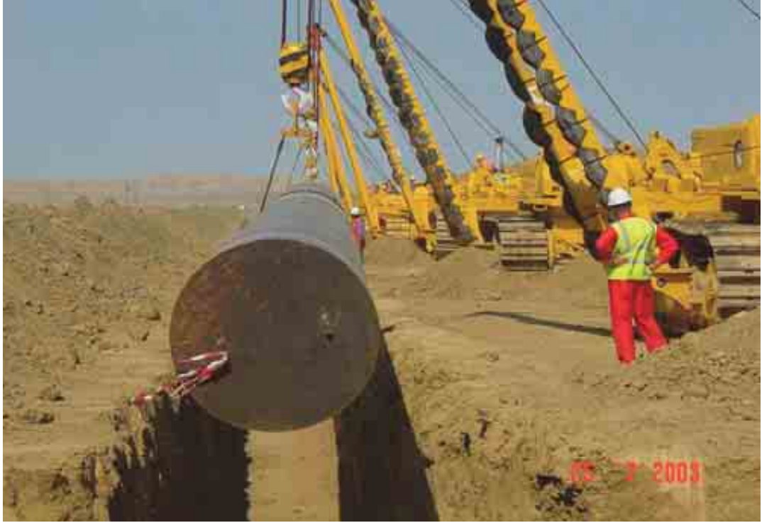
Fotoşəkil 5-4: Boru Kəmərinin Xəndəyə Endirilməsi
