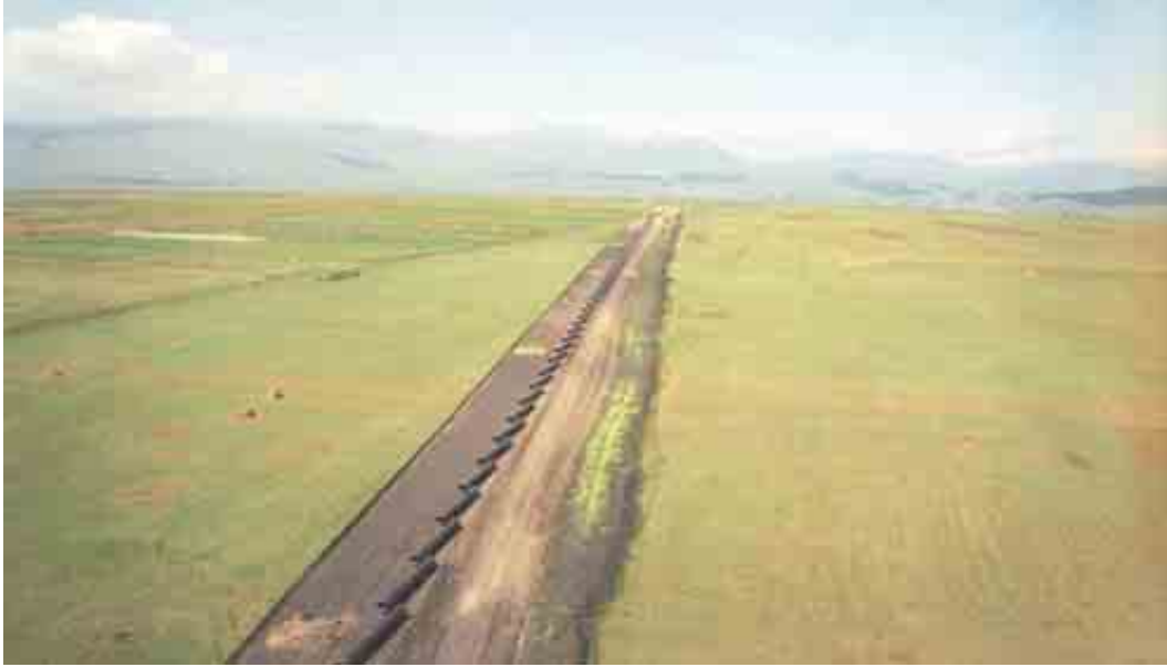
Fotoşəkil 5-2: Torpağın Üst Qatı Götürülmüş KS və Boru Kəmərinin Qaynaq edilmək üçün hazır Şəkilə Uc-Uca Düzülməsi
