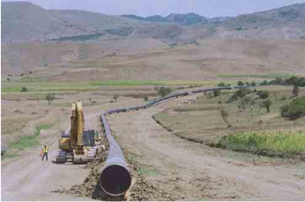
Fotoşəkil 5-3: Qaynaq Olunmuş Boru Kəməri
