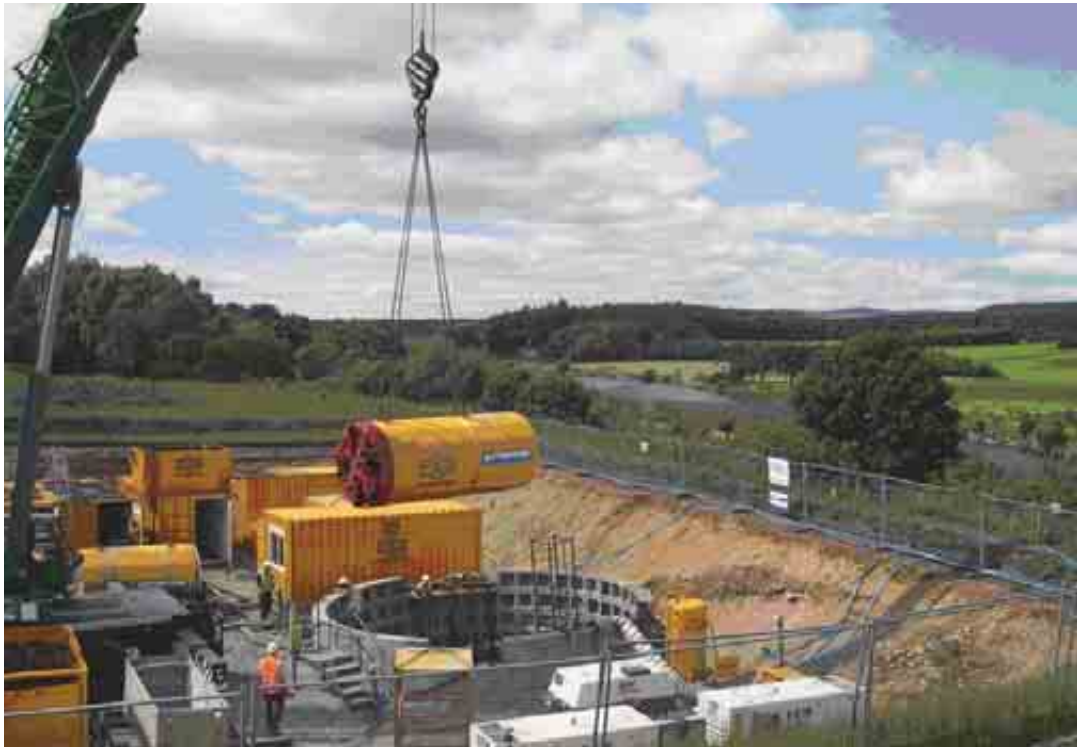
Fotoşəkil 5-5: Çayın Aşağı Hissəsində Mikrotunel Çəkilişi
