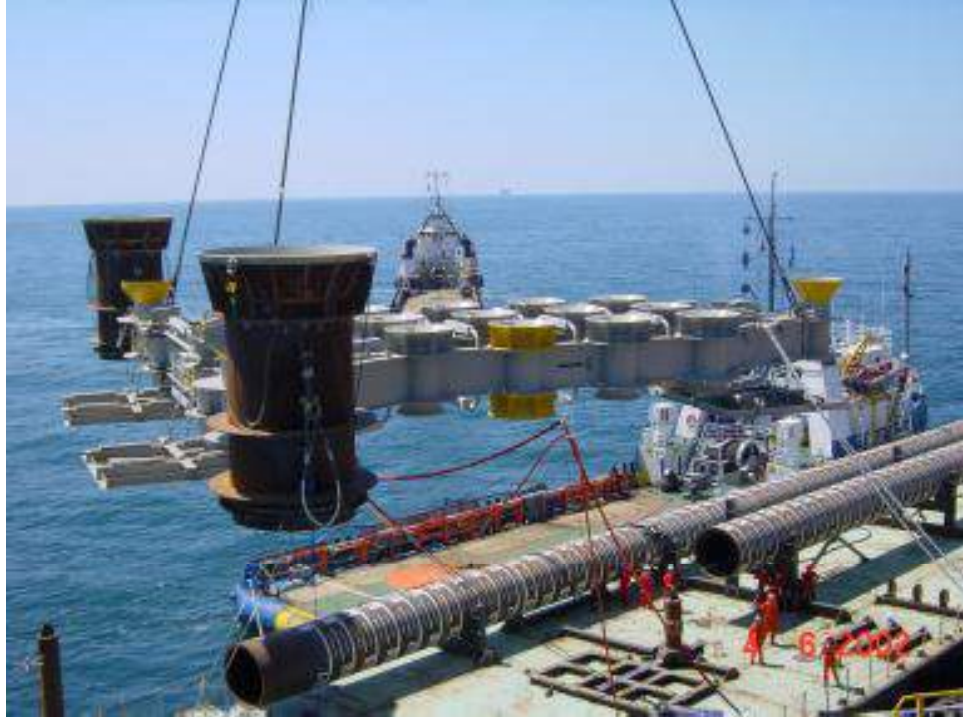
Şəkil 0.7:Faza 1 dayaq tavasının quraşdırılması
