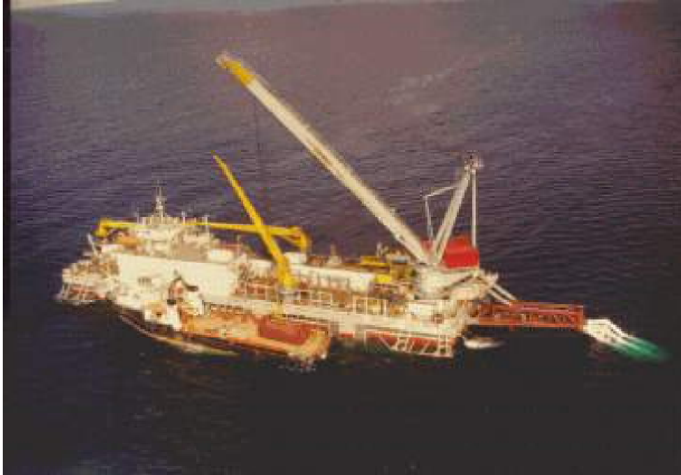
Şəkil 3.32. Borudöşəyən gəmi İsrəfil Hüseynov
